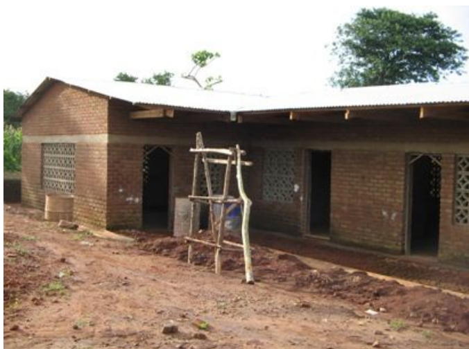
dočasně zastavená stavba školní budovy I
