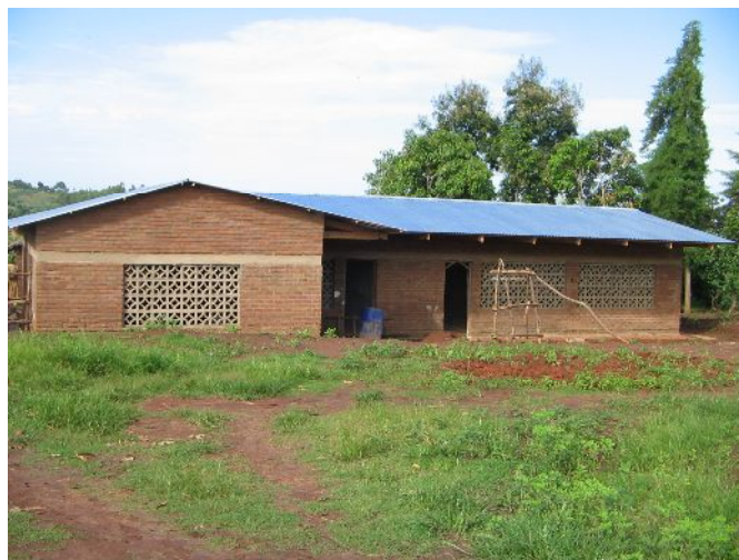
dočasně zastavená stavba školní budovy II
